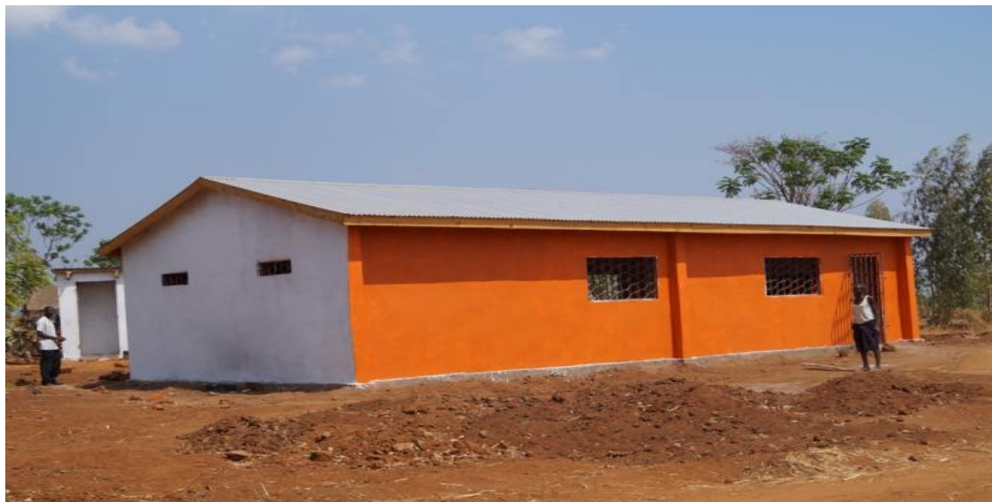
Fast abgeschlossen: die Arbeiten am Lernzentrum in Teula.
